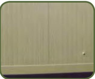
Les parois extérieures sont formées par des panneaux modulaires à encastrement composés par 2 tôles extérieures zinguées recouvertes par 2 couches de vernis 5/10 interposée auxquelles il y a une couche de matériel isolant en mousse de polyuréthane rigide auto-éteignant non hygroscopique d'une densité totale de 40 +/- 4 Kg/m<sup>3</sup>.
